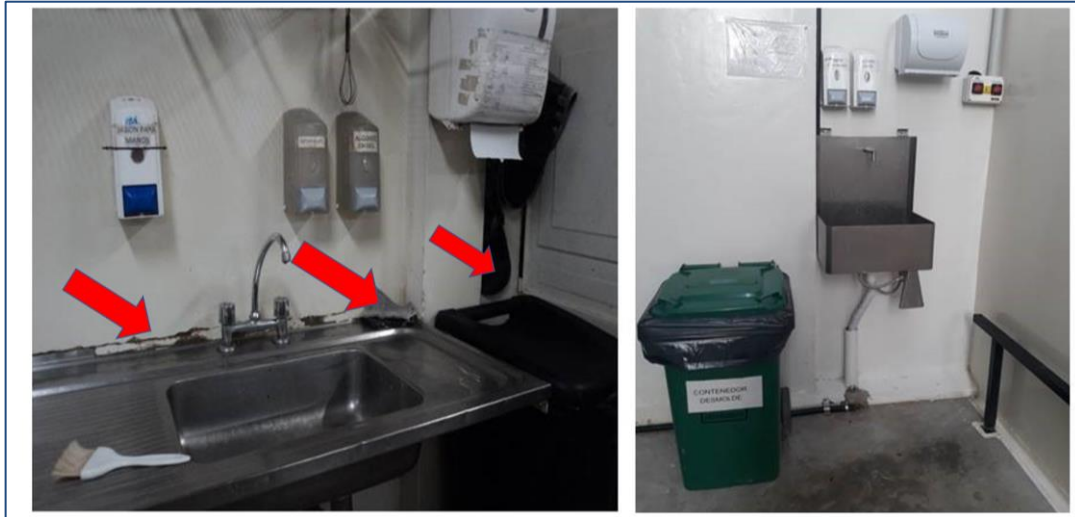
Figura 11. Lavados de manos y filtro sanitario.
